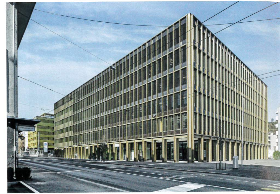
Der Eingang zum neuen Stadthaus befindet sich am Stadtplatz in der starken Ecke des Gebäudes zur Luzernerstrasse.
