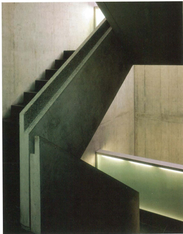
Vorgefertigte Treppe im massiven Kern
