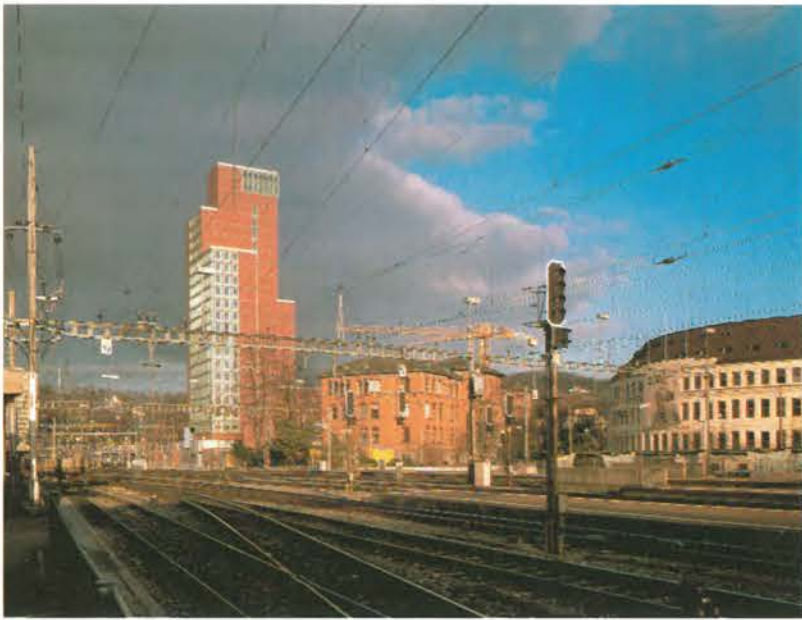
Gleisfeld auf der einen Seite, Gartenstadt auf der anderen Seite: Der Swisscom Tower versucht dazwischen zu vermitteln
