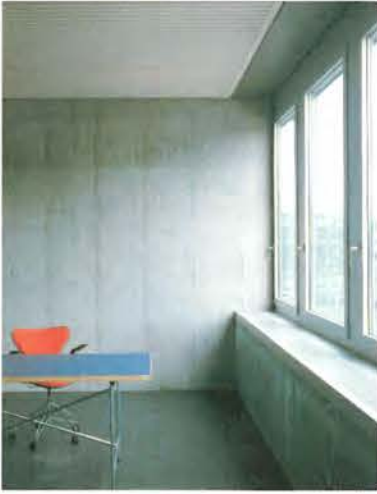
Die Büroräume sind schmucklos und funktional: Weisszementplatten an der Decke reflektieren das Licht und dämmen den Schall. Die Hälfte der Decken-Betonfläche ist Speichermasse für die Nachtauskühlung
