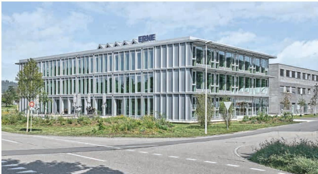
**Der Erweiterungsbau mit seiner vertikal gegliederten Aluminiumfassade** ist mit dem bestehenden Holzmodulgebäude dahinter baulich und funktional eng verbunden. Gleichzeitig bewahrt er eine starke eigene Präsenz.
