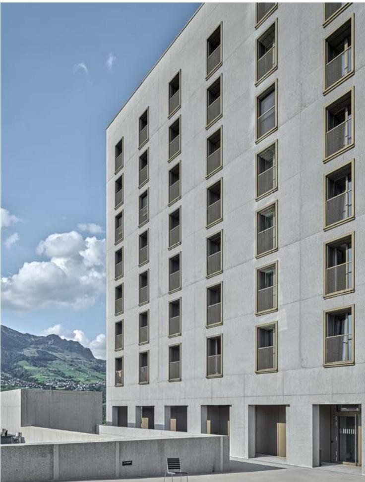
**Die äussere, sich selbst tragende Sichtbetonfassade erfüllt die Minergie-P-Anforderungen.**
