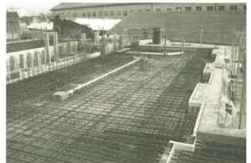
Abb. 52: Decke über Erdgeschoss Die Rücksprünge bei den Deckenstirnelementen indizieren die Lage der französischen Fenster
