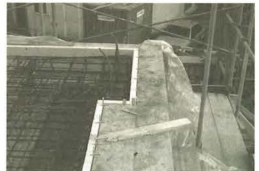
Abb. 51: Detailaufnahme Schalung Das Deckenstirnelemente fungiert als Abschaltung; Gipsperlätchen gewähren den Abstand zur Dämmung.
