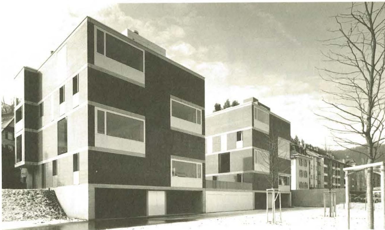
Abb. 35: Blick von der «Merker»-Wiese Der Niveauunterschied legt das Untergeschoss offen
