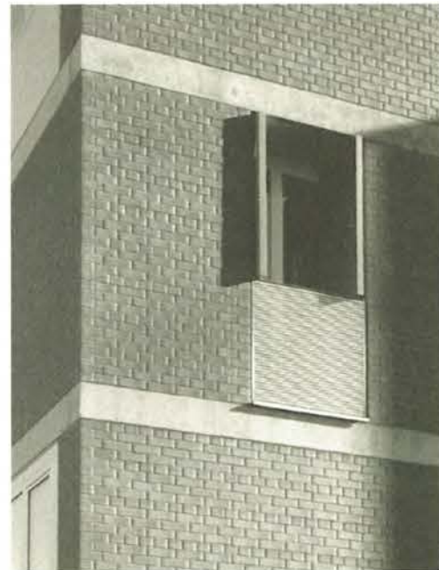
Abb. 55: Detailaufnahme Wetterschutzgitter als Brüstung und Jalousie
