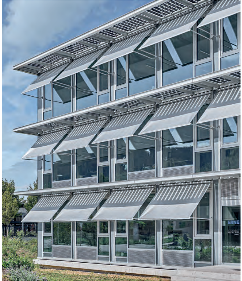
De ramen zijn hout-aluminium constructies uit eigen fabriek: houten kozijnen en ramen met een dunne bekleding van aluminium.
