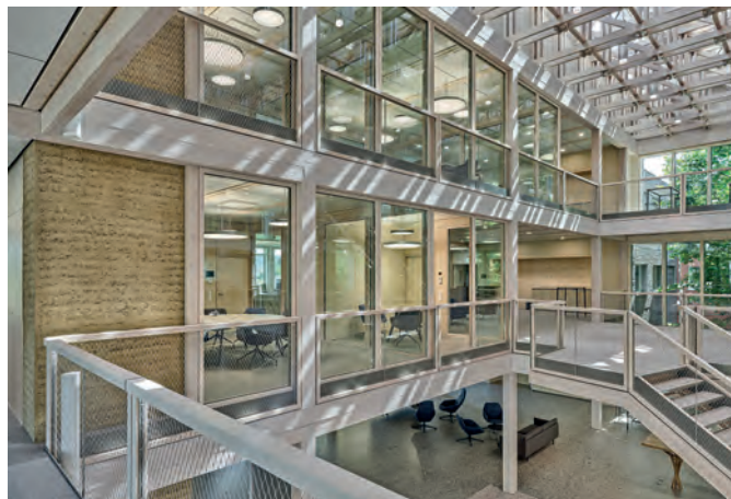
De sheddaken zorgen voor lichttoetreding. Het licht wordt door de draagconstructie fraai gefilterd.
