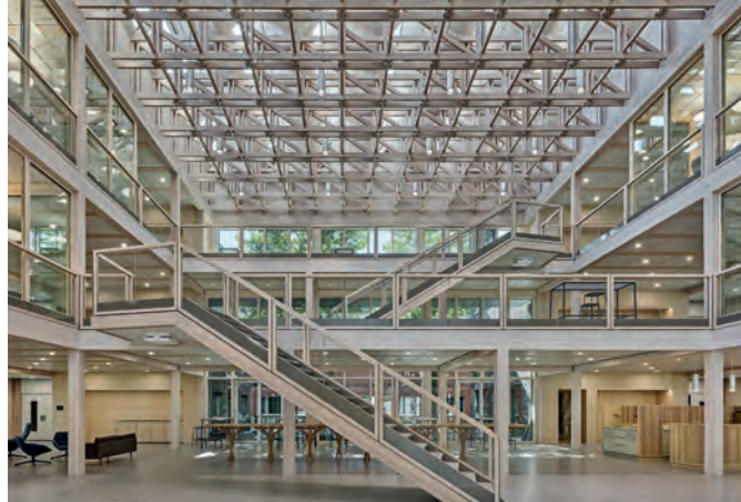
De dakconstructie is speciaal voor dit atrium ontworpen en overspant 14 meter. Parallelle vakwerkliggers zijn verbonden door houten balken om ze te fixeren.
