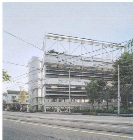
Erster Rang der Schulanlage Brunnenhof
