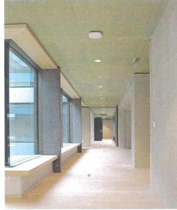
Für die Realisierung des Farbleitkonzeptes in den Klinikbauten wurden die frei gestaltbaren Betondecken mit «faceal Colour» farbig ausgeführt.
