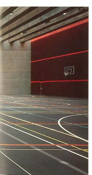
Das Deckentragwerk der oberen Halle nimmt die Monumentalität der mächtigen Stützenreihe der Fassade auf, indem es mächtige Stahlträger in Längsrichtung aneinanderreiht.
