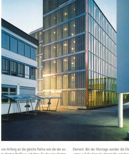
trudierten Profile zu erhalten. Da die extrudierten Baubronze-Profile in Kontakt mit Sauerstoff chemisch reagieren und eine natürliche Schutzschicht des Materials bilden, erfolgte die Handhabung während der Fabrikation und vor allem der Montage mit grösster Sorgfalt. Um bleibende Fingerabdrücke zu vermeiden, musste die Fassadenmontage der Teile mit Handschuhen ausgeführt werden.
