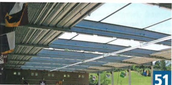
Überspannte Stahlkonstruktion zur Beschattung, Reitsportzentrum Gümligenfeld
