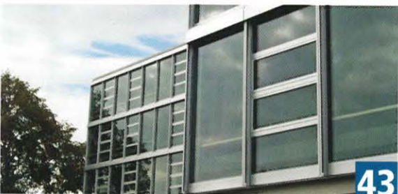
Fassadensanierung Schulhaus Wasgenring, Basel
