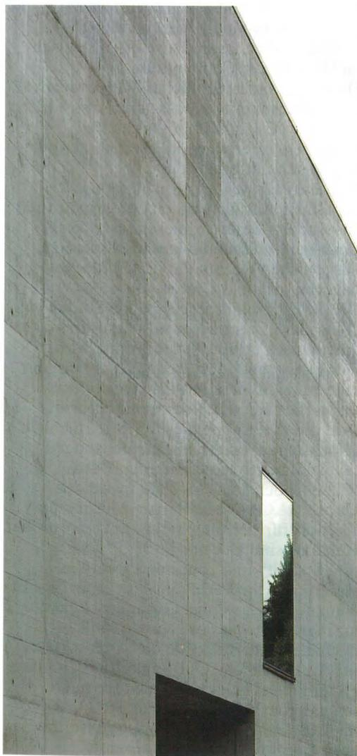
**Eine rund hundert Meter lange Sichtbetonfassade bildet den Rücken dieses Erweiterungsgebäudes einer Dorfschule in der Schweiz. Außen bündige Glasflächen, eine sorgsame Schalung und eine fugenlose Betontechnik machen diese Wand zum gestalterischen Ereignis. Fotos: Reinhart Zimmermann, Zürich**
