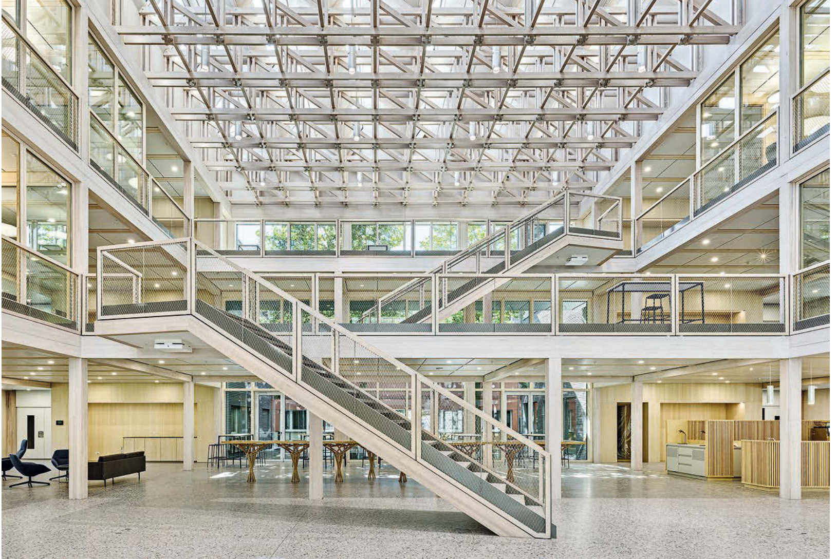
Die fein gegliederte Dachkonstruktion mit Sheddach bringt viel Tageslicht ins Atrium und in die angrenzenden Bereiche. • The finely structured shed roof brings plenty of daylight into the atrium and the adjacent areas.
