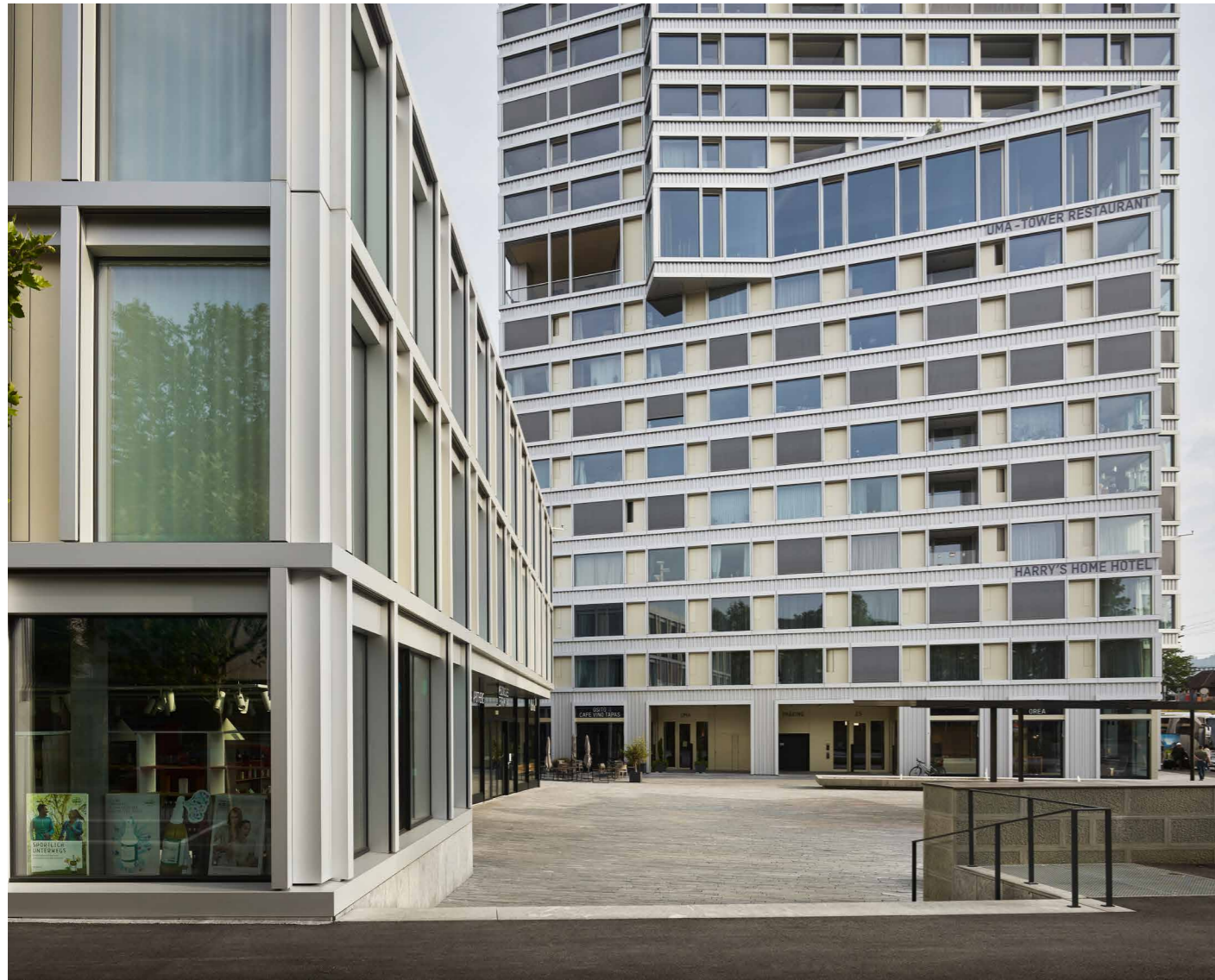
Die Fassade mit den umlaufenden Geschossbändern aus Glas und Aluminium gliedert den Baukörper und schafft eine adäquate Massstäblichkeit.
